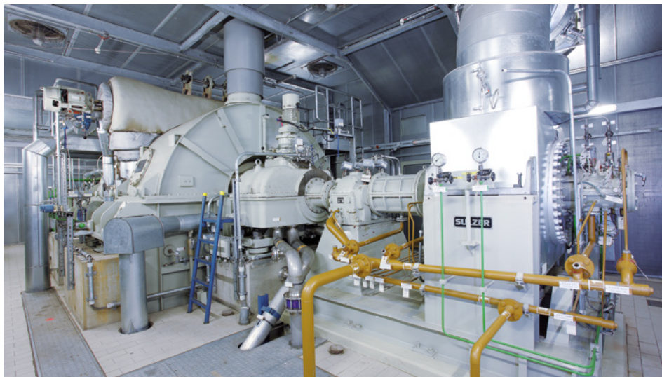
Dampfturbine, Braunkohlekraftwerk
